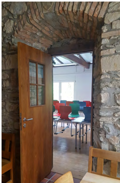
Neue Wege in alten Mauern: Der Durchgang vom Speisesaal zum Unterrichtsraum
